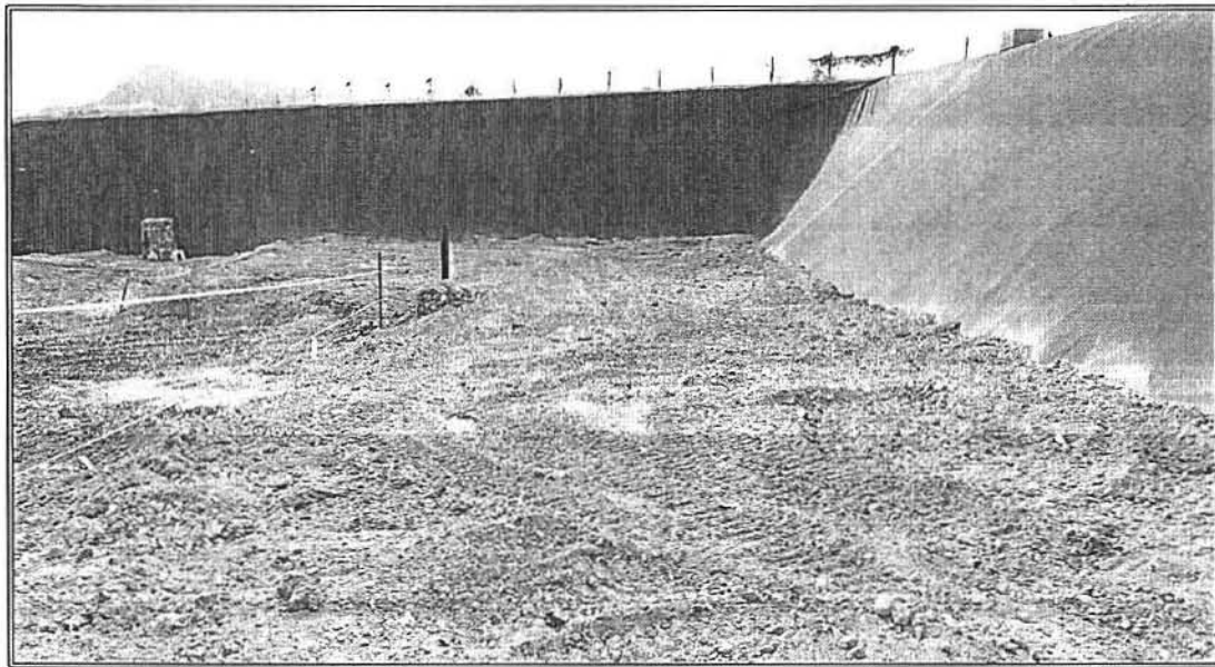
Vista panorámica de la tres micro celdas conformadas y con la cobertura adecuada, con las medidas de 17 x 10 metros, espesor de 0.90 metros y una pendiente de 3 %.
